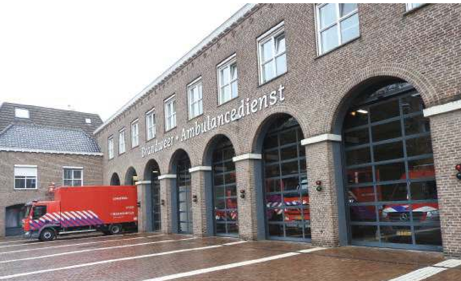
De bouwregelgeving gaat niet over de inzet van de brandweer.
