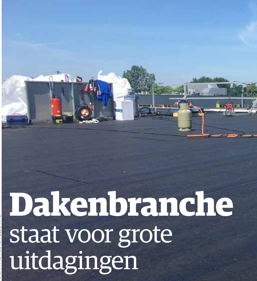
FOTO: VAN VENROOY DAKBEDEKKING
