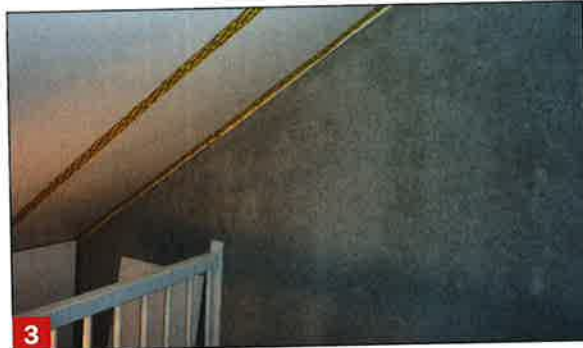
Tape als luchtdichting
