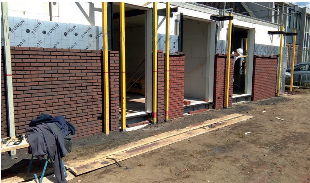
Woningen in Renkum die al aan de BENG-eisen voldoen in aanbouw. Een project van Vivare en OptimumPlus, opgeleverd in 2016.
