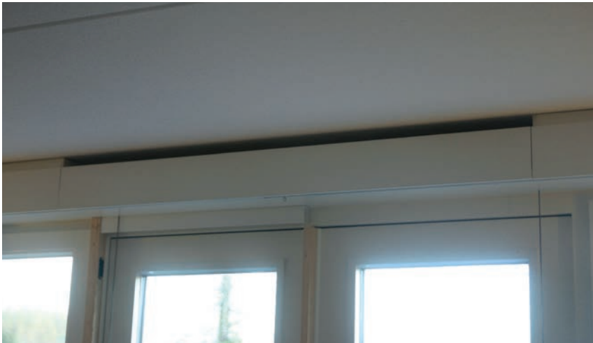
Ventilatiesysteem C in de Brabantwoning: een koof voor de ventilatieroosters zorgt ervoor dat koude buitenlucht langs het plafond wordt ingeblazen.
