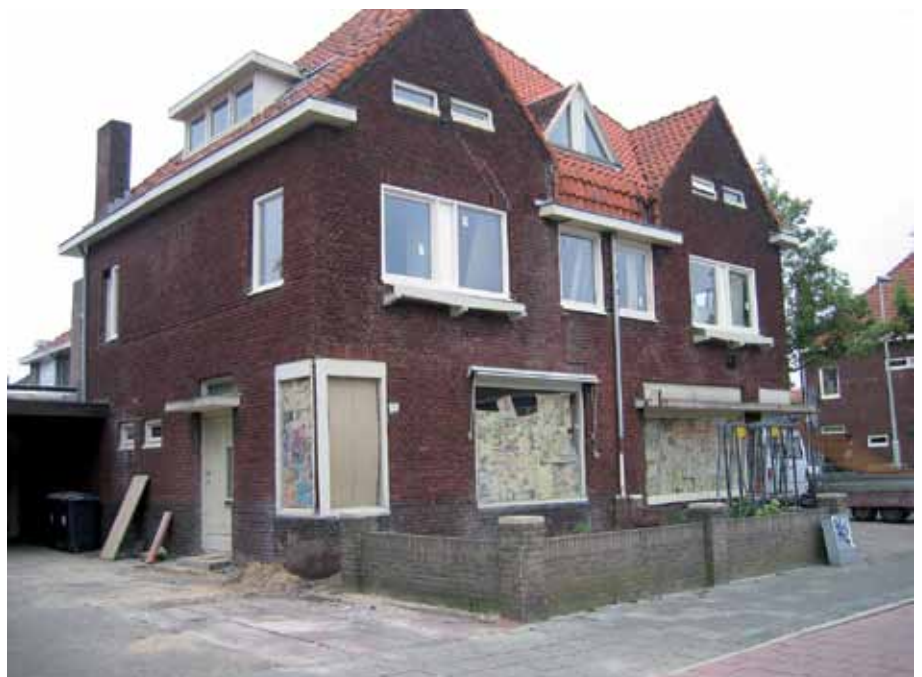
Vóór 1992 waren er nauwelijks eisen voor bestaande gebouwen.
