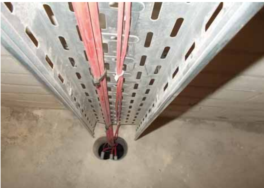
Afdichting in een brandwerende constructie.
