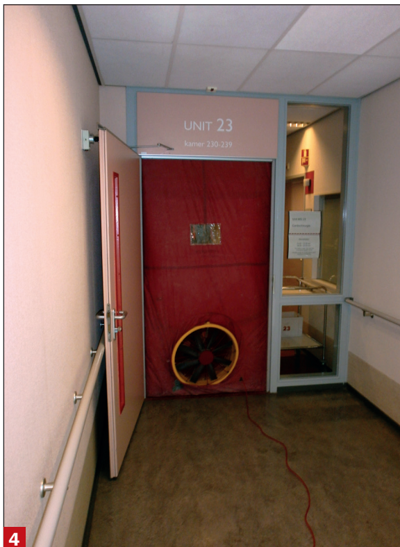
4 Blowerdoortest ter bepaling van de luchtdichtheid van de scheidingsconstructies van de corridor
