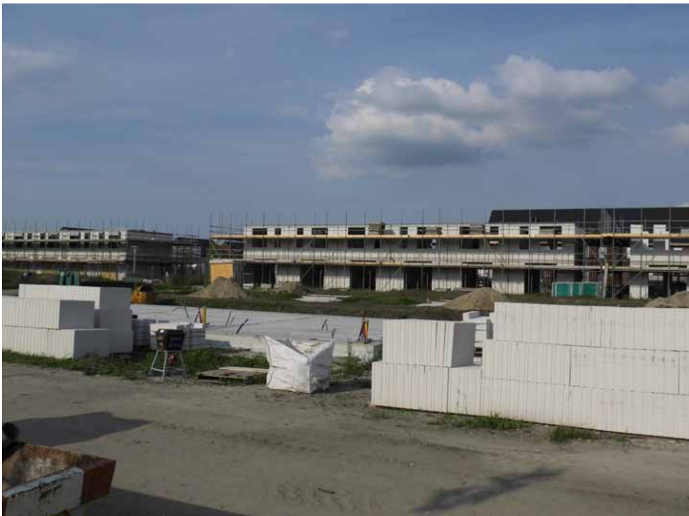
Foto: T.Haytink, Nieman Raadgevende Ingenieurs.
