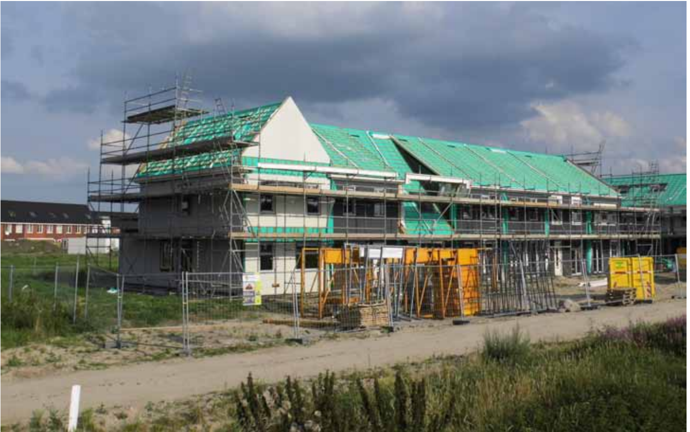
Foto: T.Haytink, Nieman Raadgevende Ingenieurs.
