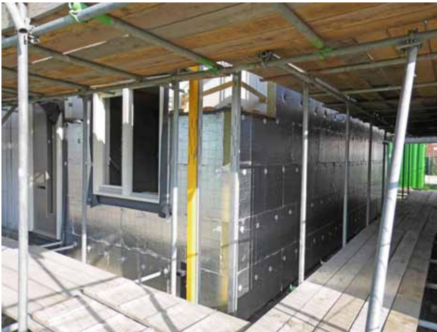
Foto: T.Haytink, Nieman Raadgevende Ingenieurs.
