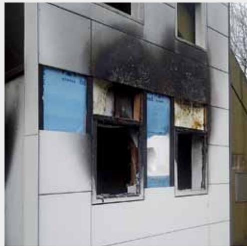
STOOF-ISOLATIEMATERIAAL TESTEN IN SANDWICHPANELEN.
