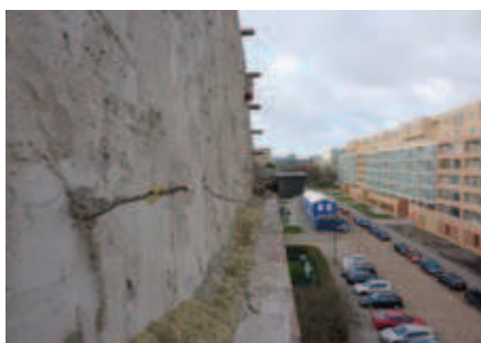
Vlnr: Te weinig spouwankers, te korte spouwankers en slecht hechtend metselwerk (beeld: M. Ebberink)
