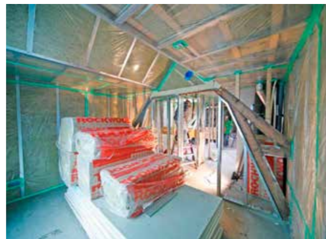
figuur 2b: binnengevelisolatie De Sleephelling te Rotterdam
