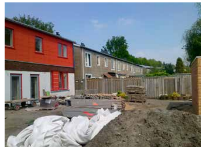
Passief Renoveren tijdens de uitvoeringsfase figuur 2a: buitengevelisolatie Velve-Lindenhof te Enschede
