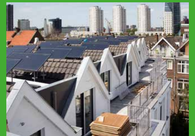
Figuur 9: Buitengevelisolatie achtergevel project 'Sleephelling' te Rotterdam
