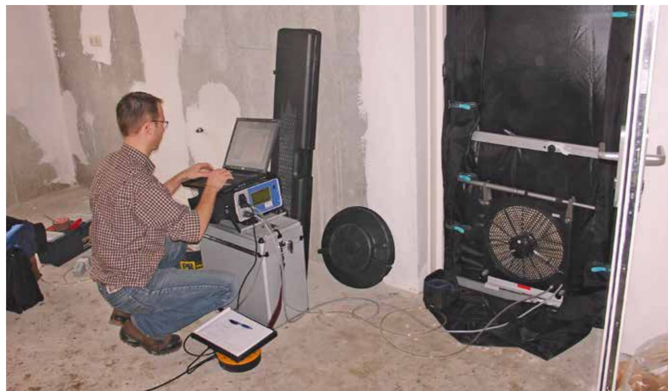
Figuur 7: Controle uitvoeringsfase door middel van luchtdichtheid en thermografie
