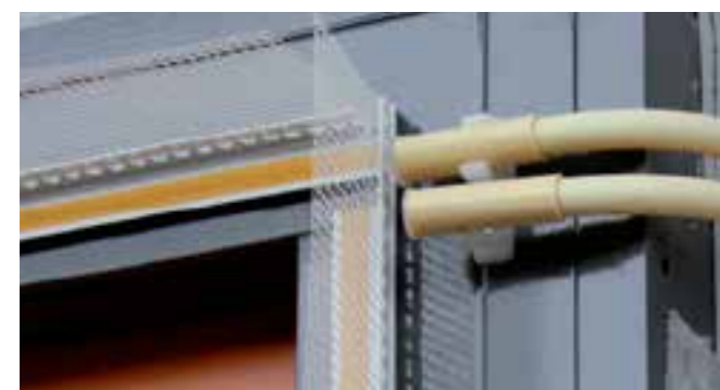
Figuur 4: Luchtdichte aansluiting rondom kozijnen en doorvoeringen
