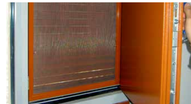
Figuur 5: Zomernachtventilatie voorziening
