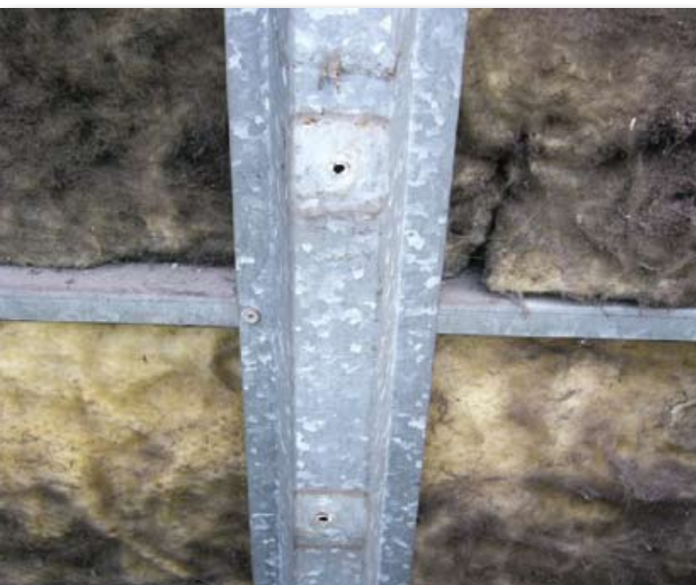
Nog een voorbeeld van een verzinktstalen achterconstructie in de spouw bij een meer dan 20 jaar oud gebouw.
