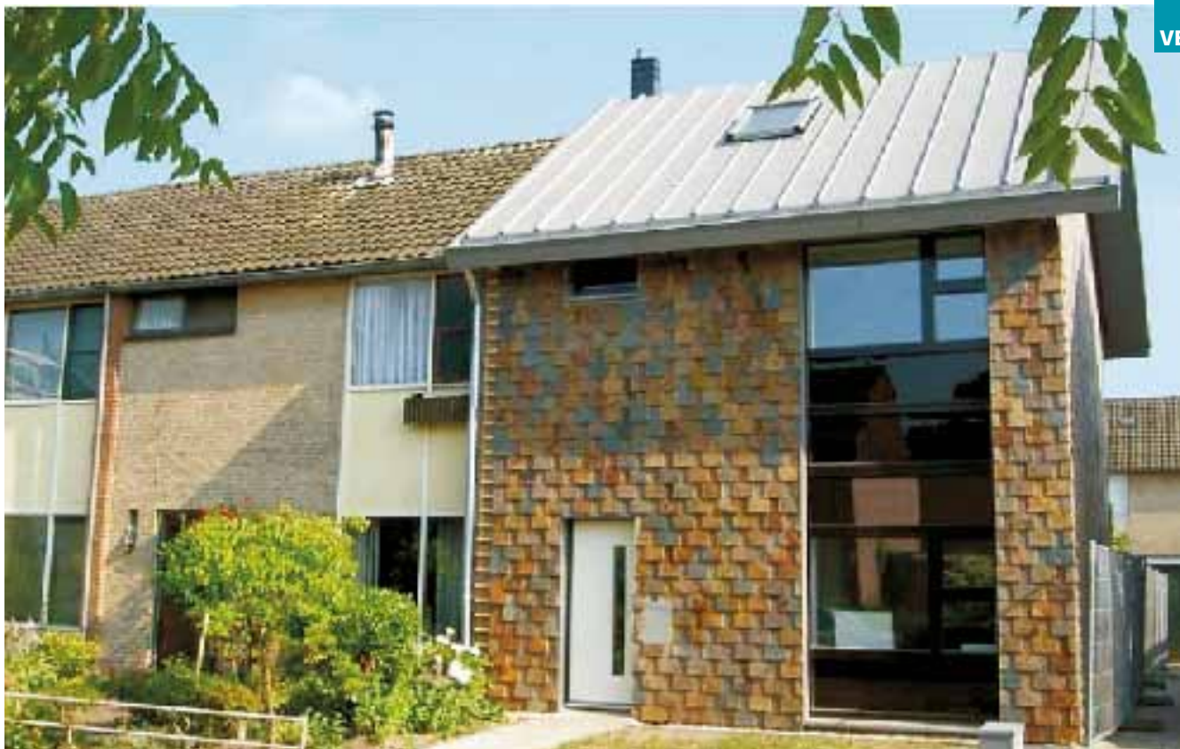
Proefwoning De Kroeven. Nieuwe isolatieschil biedt kans op een ingrijpende energetische en architectonische verbetering. Bijzonder is dat de bewoners geen wisselwoning nodig hadden en dat deze make-over in 15 dagen gerealiseerd is.
