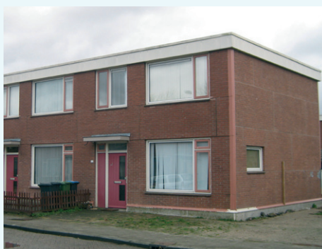
Bestaande situatie complex KleurrijkWonen te Culemborg
