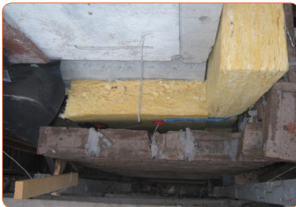
Foto 6. Ter plaatse van uitwendige hoeken kan men de isolatiehoeken dichtbinden met speciaal voor dit doel ontwikkelde 'hoekbinders'.
