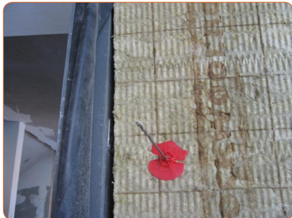
Foto 7. Tegen onder andere kozijnen moet het isolatiemateriaal strak aansluitend worden aangebracht. In dit geval ontstaan thermische verliezen doordat dat niet is gebeurd.
