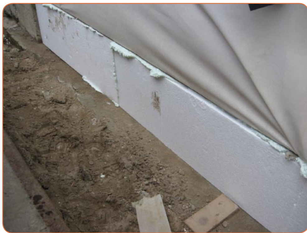
Foto 3. Breng tussen een HSB-element en de funderingsbalk de isolatie strak aan. Waar nodig kunnen naden worden afgeschuimd.
