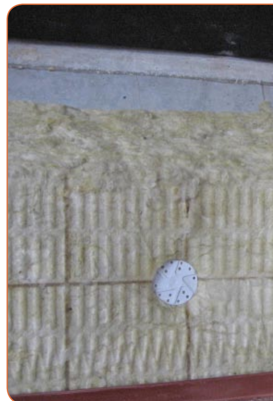
Foto 2. Zo hoort het: tussen de brackets van geveldraggers moet strak/sluitend worden geïsoleerd. Daarnaast moet de bovenzijde van de isolatie (gesloten cellen of harde persing) worden afgeschuind. Hier wordt namelijk een waterwerende folie aangebracht.
